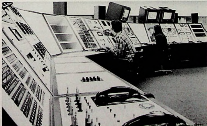
Afb. 2. Links en midden de beide audio contributiepanelen met hun meetapparatuur. Geheel links één van de telefoonpanelen en rechts de video schakel- en meetpanelen.
